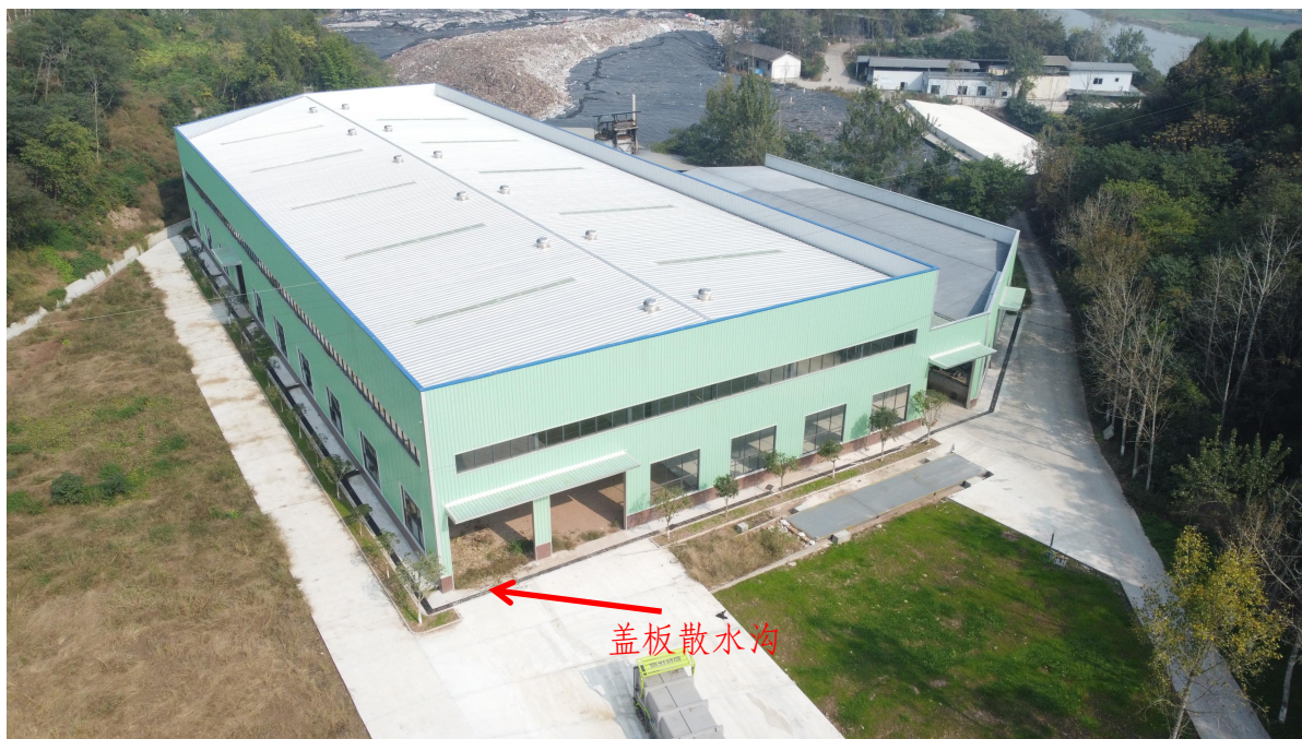
图 2.2 餐厨垃圾处理厂房周围盖板雨水沟
