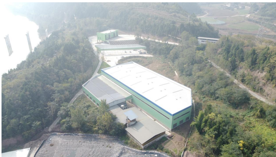
照片 2 项目整体建设现状 - 已完工 (从北向南拍摄) (2023 年 12 月)
