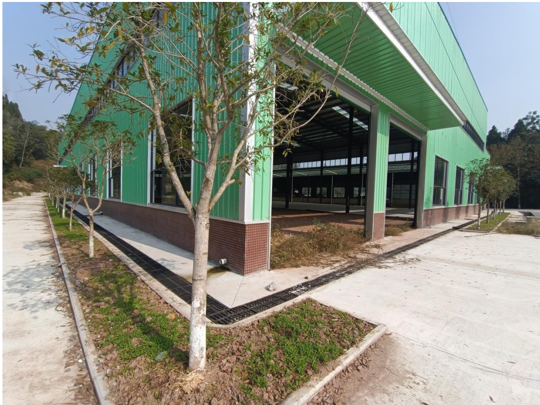
照片 6 餐厨垃圾处理厂房周围盖板排水沟（2023 年 12 月）
