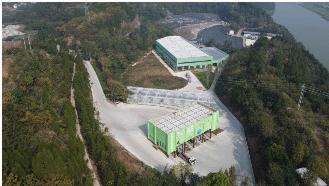
照片 1 项目整体建设现状 - 已完工 (从南向北拍摄) (2023 年 12 月)
