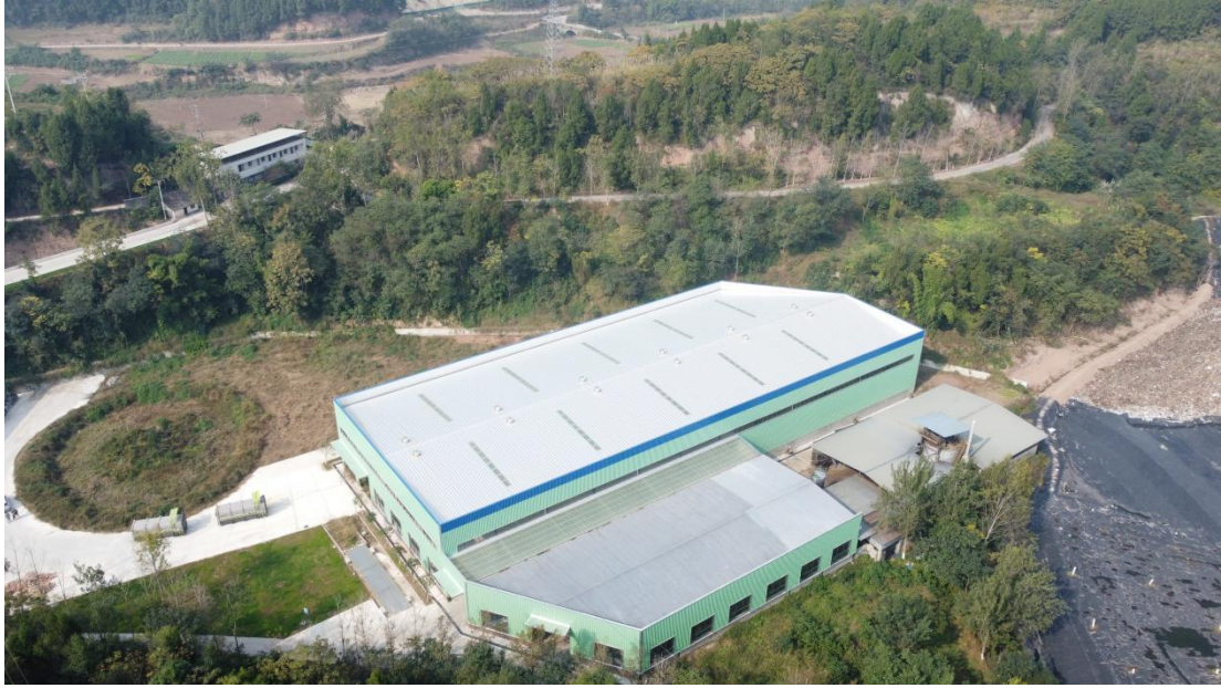
照片 3 餐厨垃圾处理厂房-已完工 (2023 年 12 月)
