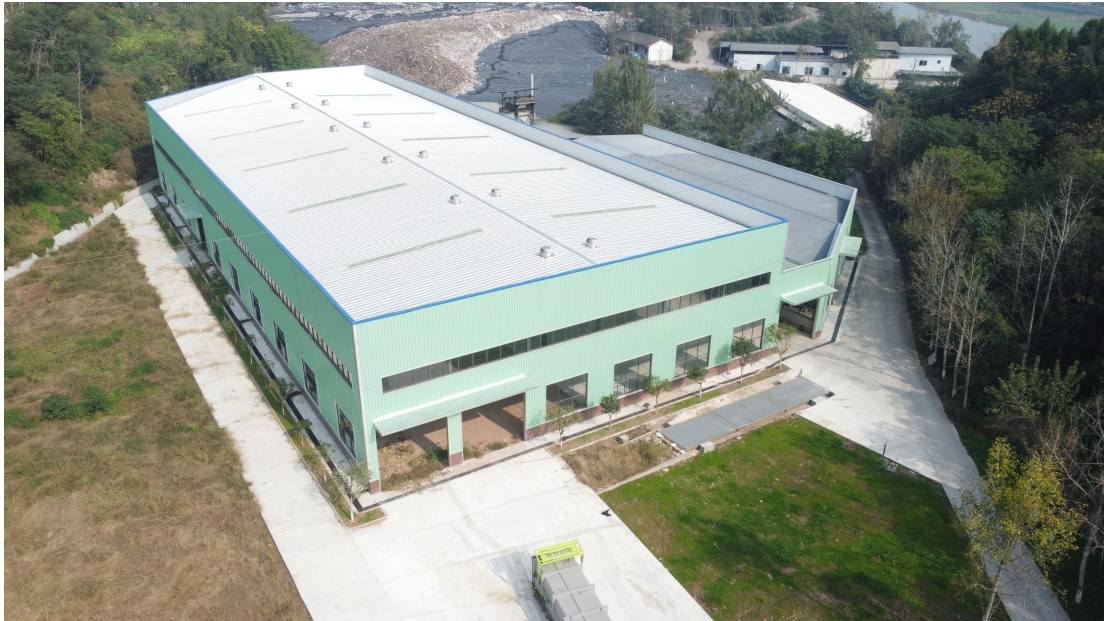
照片 5 餐厨垃圾处理厂房周围排水沟以及厂区绿化（2023 年 12 月）
