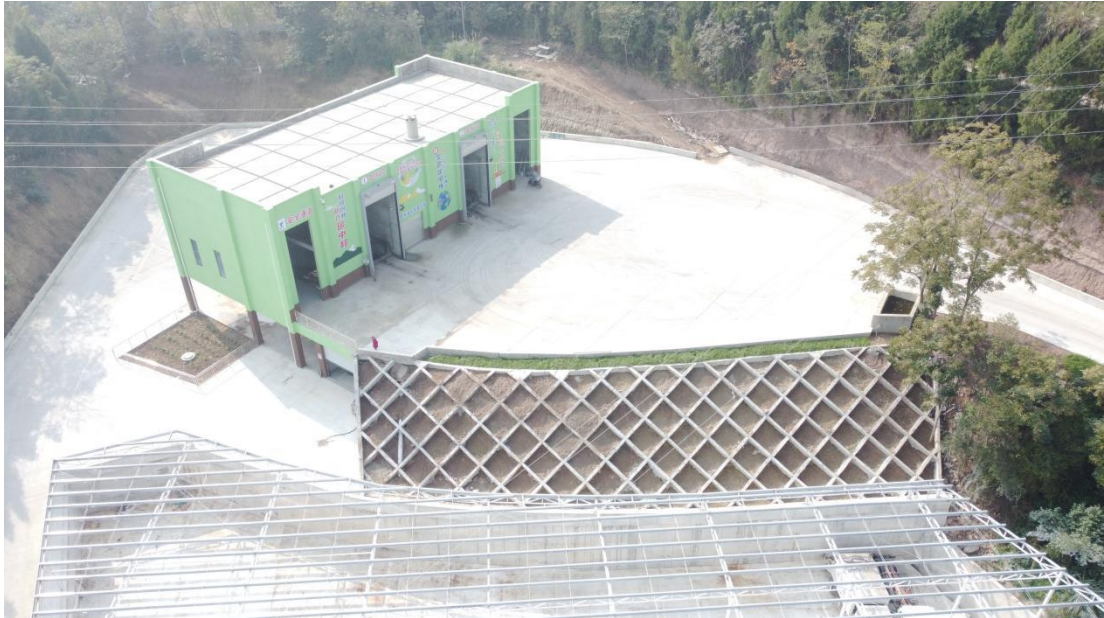
照片 4 垃圾压缩站-已完工 (2023 年 12 月)
