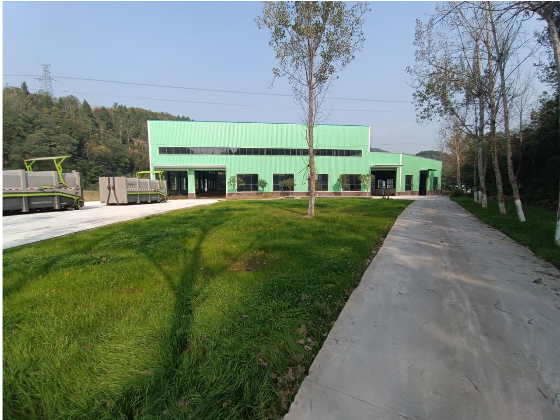
照片8 厂区绿化及室外地坪硬化（2023年12月）
