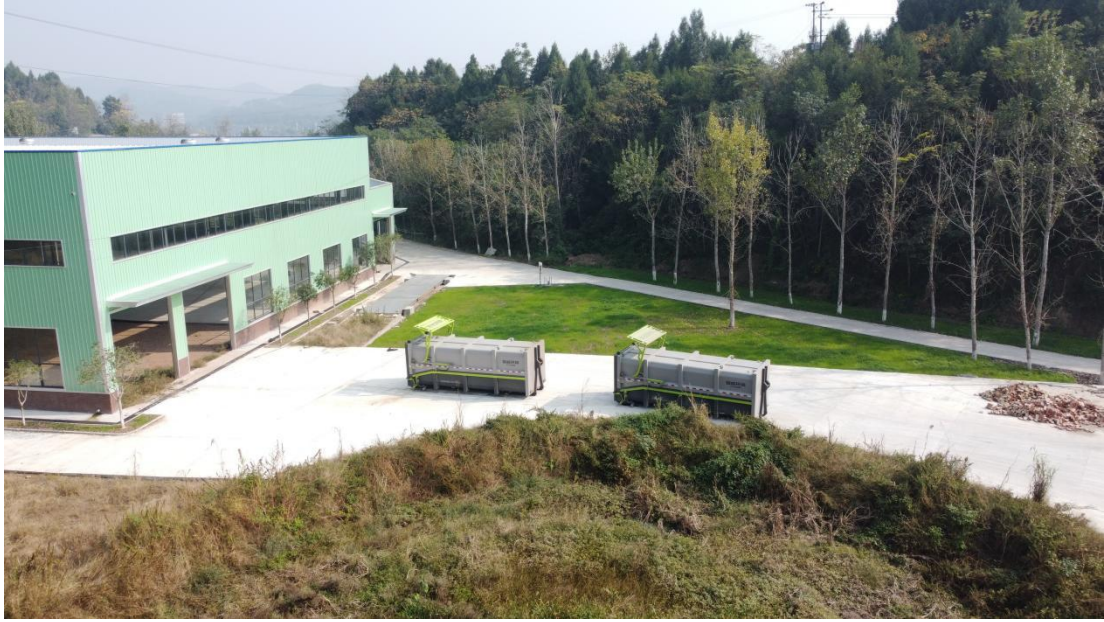
照片7 厂区绿化及室外地坪硬化（2023年12月）
