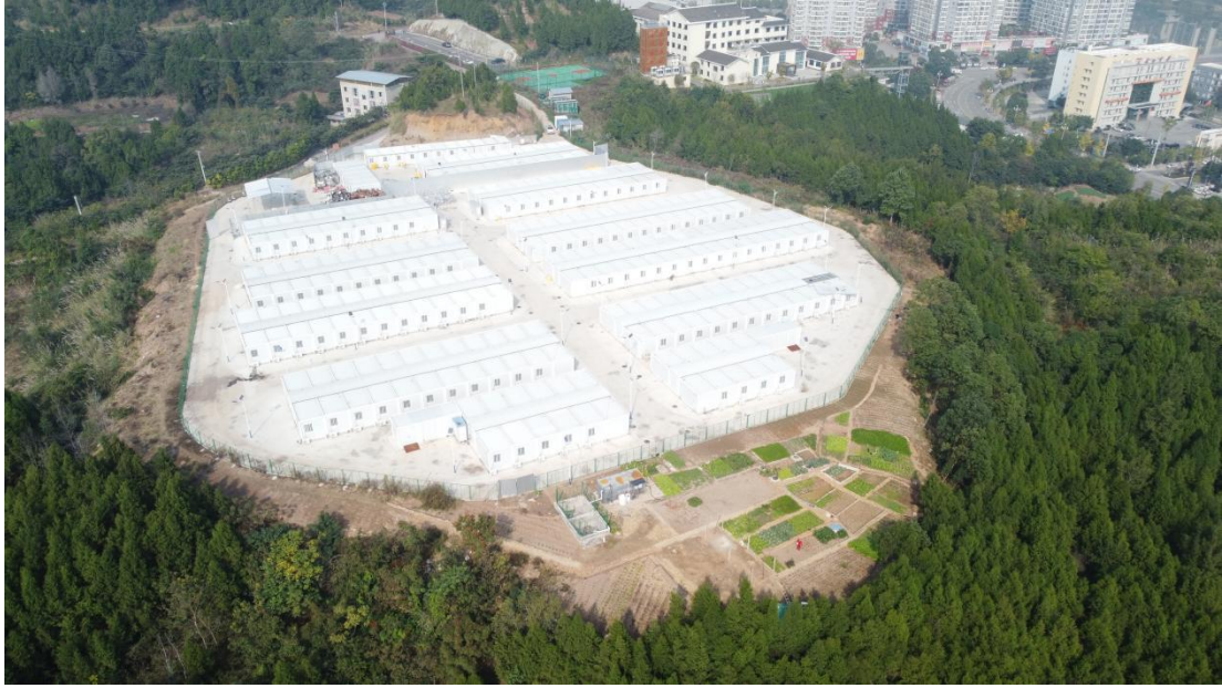
照片3 污水处理设备、集水池、化粪池 - 已完工 (2022年12月)
