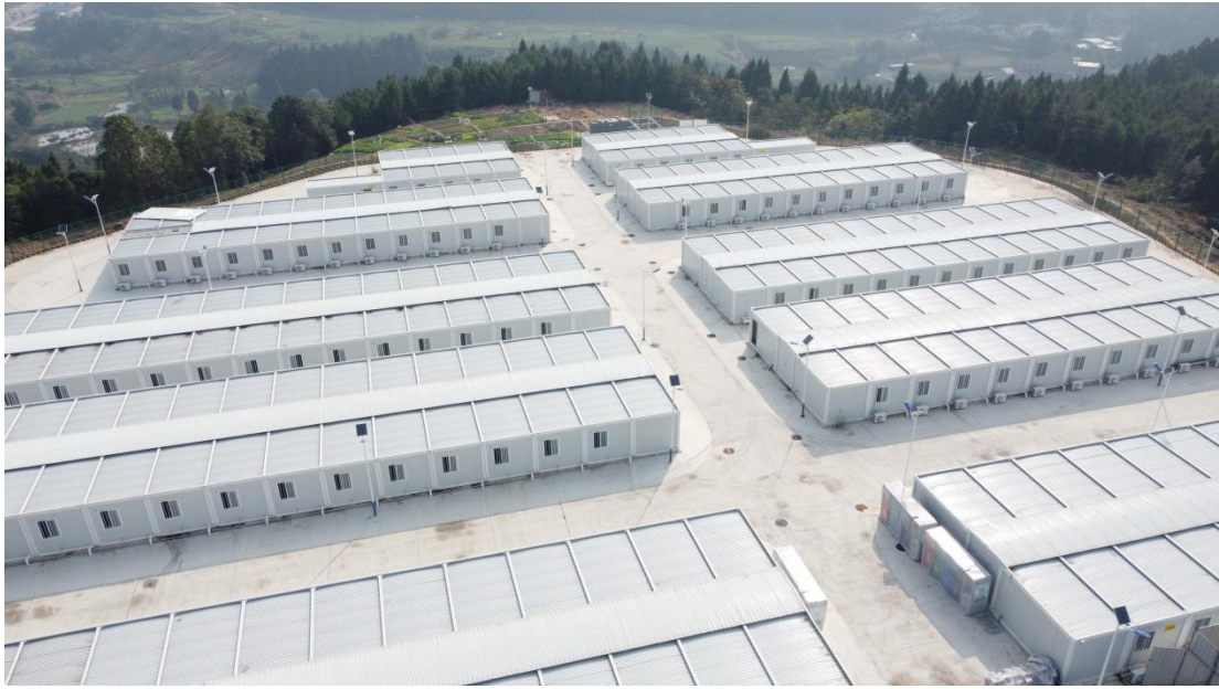
照片 5 项目场地硬化及隔离病房区 - 已完工 (2022 年 12 月)
