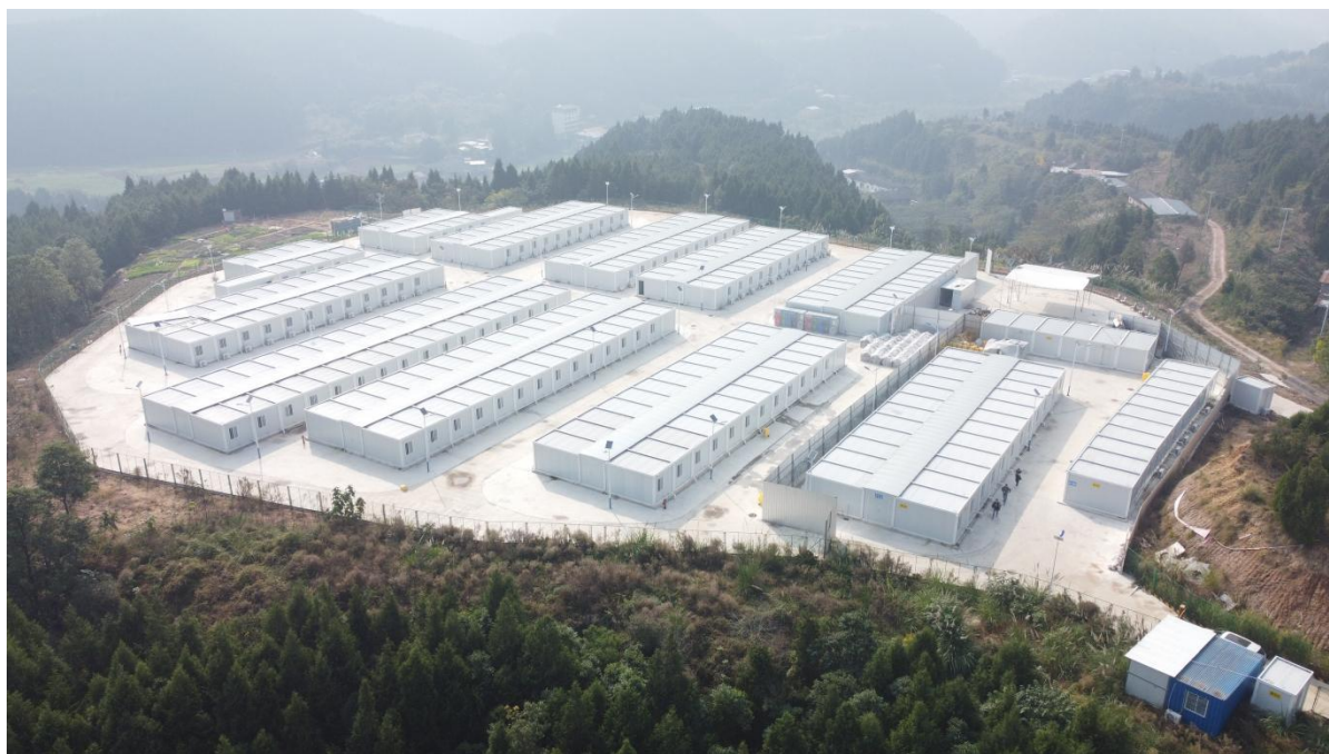
图 2.5 项目整体形象进度—已完工（2023年12月）
